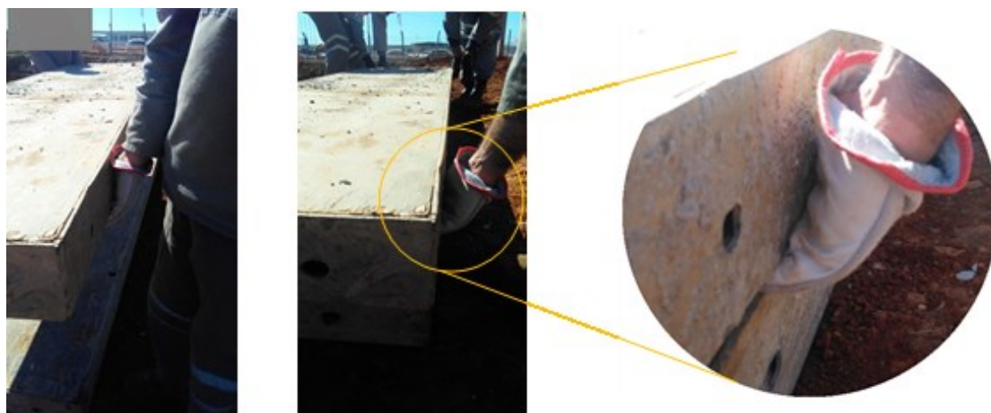
Figura 1: Manuseio das formas –Mão e dedos entre os painéis metálicos
