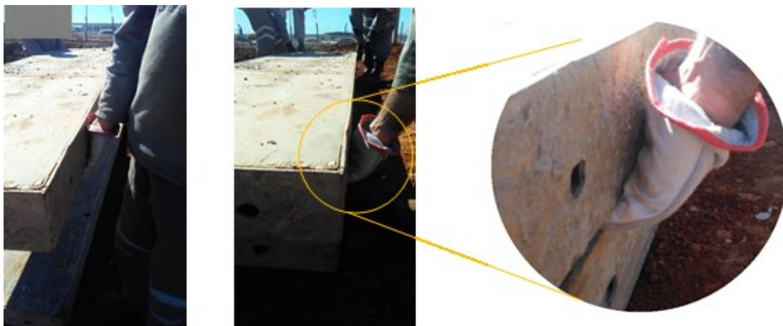
Figura 6: Manuseio das formas –Mão e dedos entre os painéis metálicos
