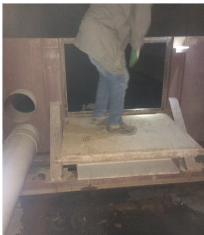
Figura 6: Comporta para contenção da água.
