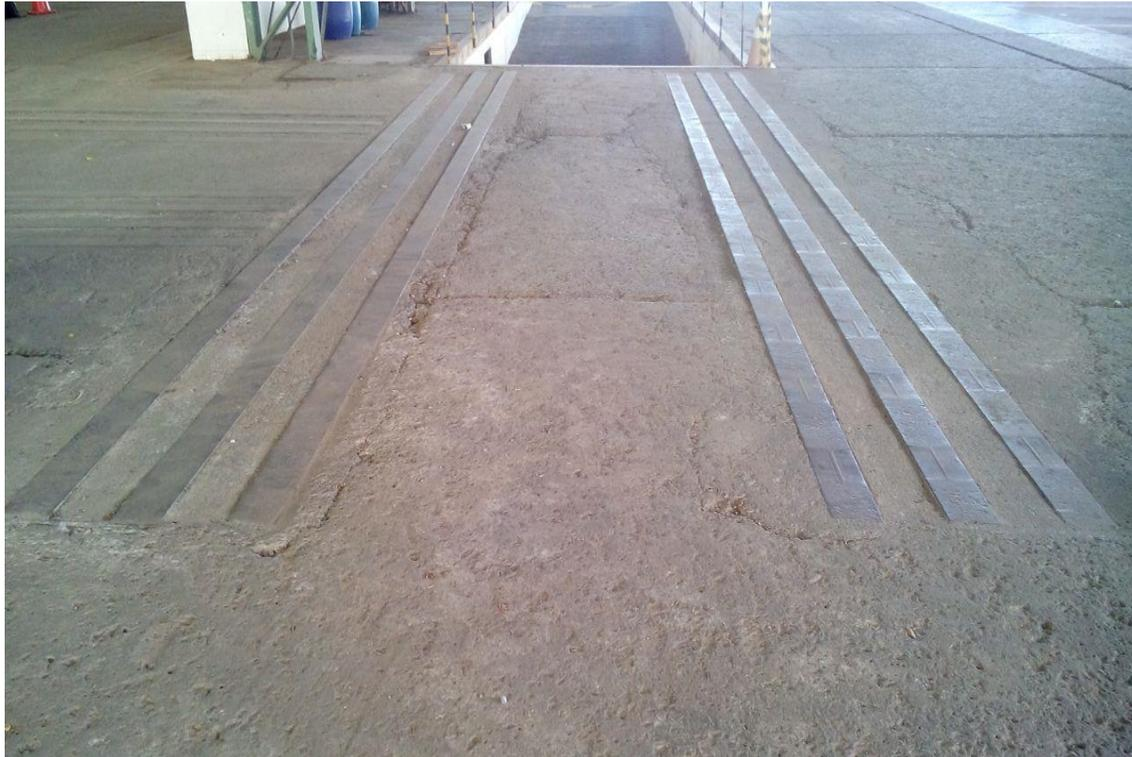
Para suportar a carga e movimentação de equipamentos pesados, com material rodante de aço, são instalados trilhos de proteção no pavimento.
