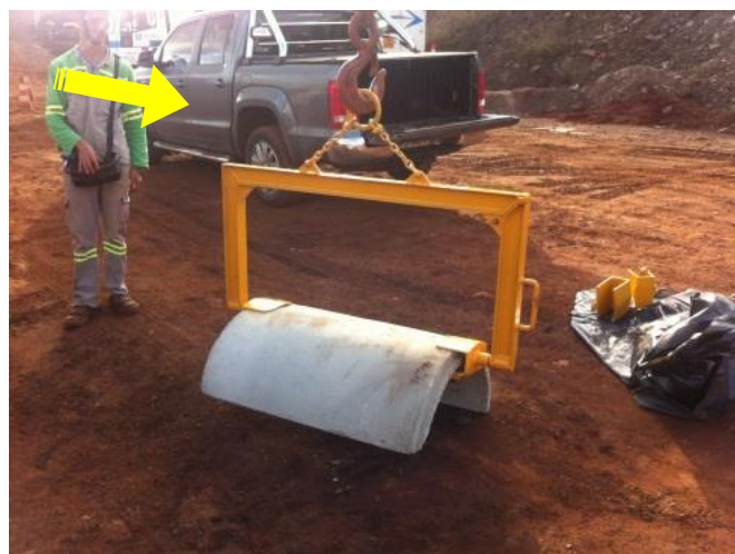
FIGURA 4 – OPERAÇÃO. Operador de Munk, fazendo a movimentação desejada da peça por controle remoto (zero contato com a peça).
