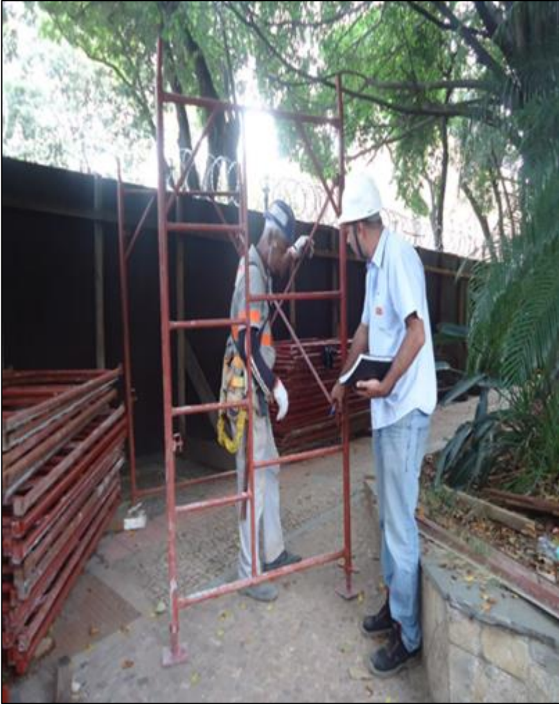
Foto : Treinamento de montagem de andaime
