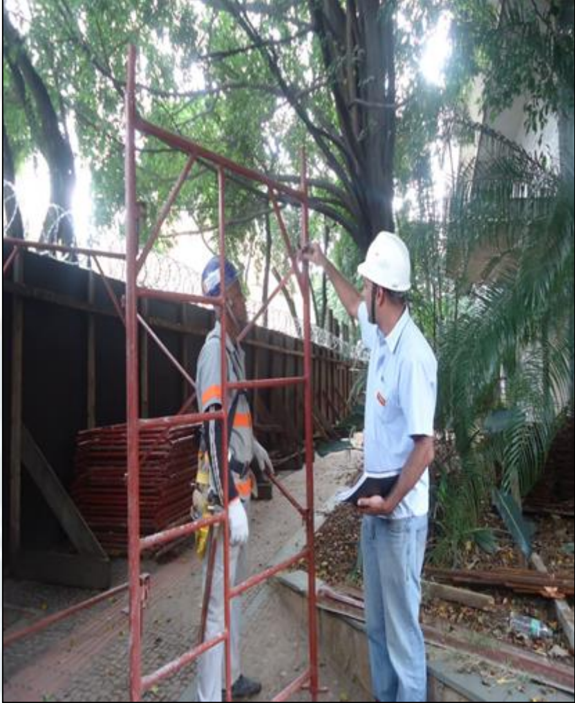
Foto : Treinamento de montagem de andaime
